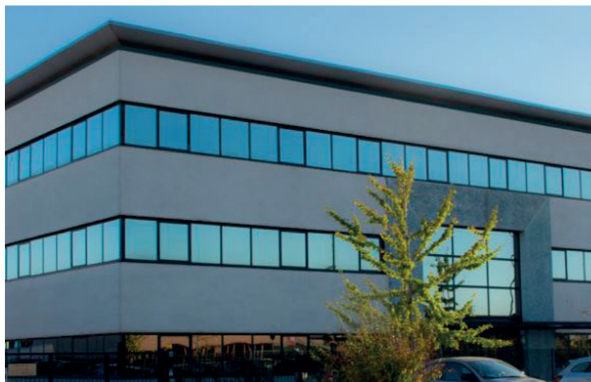
● La sede di Servotecnica a Nova Milanese.
