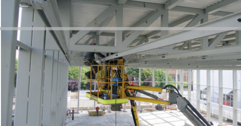
La struttura interna del padiglione è in pilastri tubolari rettangolari 260 x 180 x 12,5 mm accoppiati e innestati alle fondazioni mediante tirafondi.
