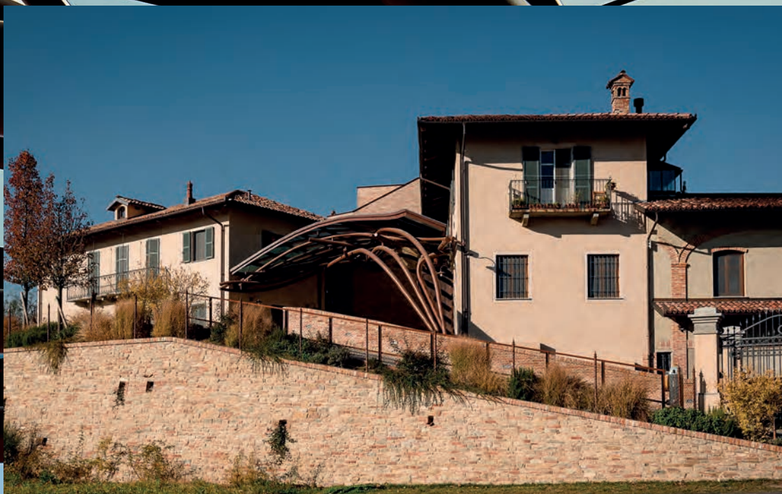
L'ampliamento delle Cantine Parusso è stato realizzato dall'architetto Dario Castellino.
