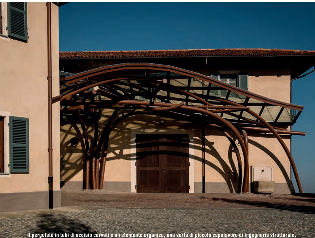
Il pergolato in tubi di acciaio curvati è un elemento organico, una sorta di piccolo capolavoro di ingegneria strutturale.
