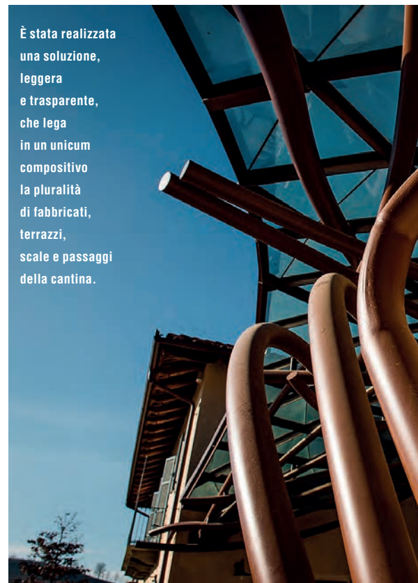
Il pergolato in tubi di acciaio curvati assolve la funzione di tettoia, per la prima fase di lavorazione delle uve,
