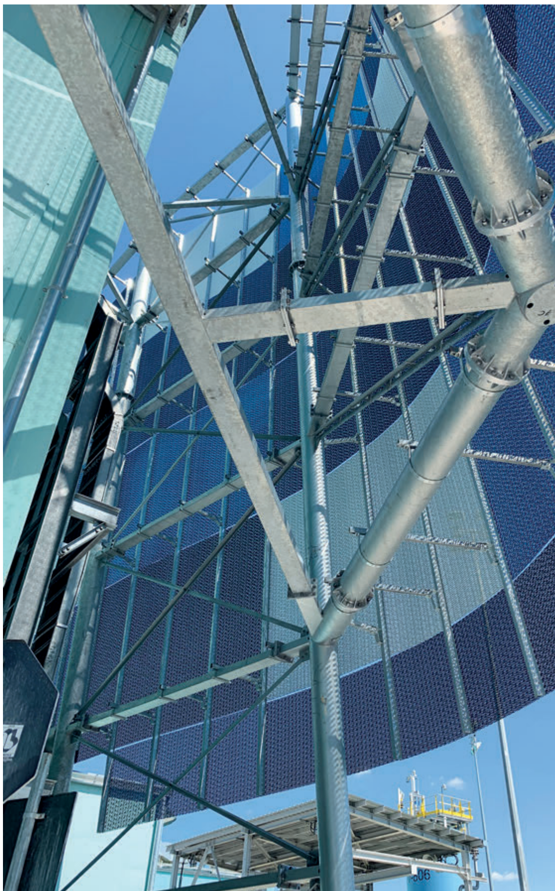
La lamiera stirata in alluminio anodizzato copre la fascia superiore delle facciate lasciando libero l'accesso pedonale e carrabile.
