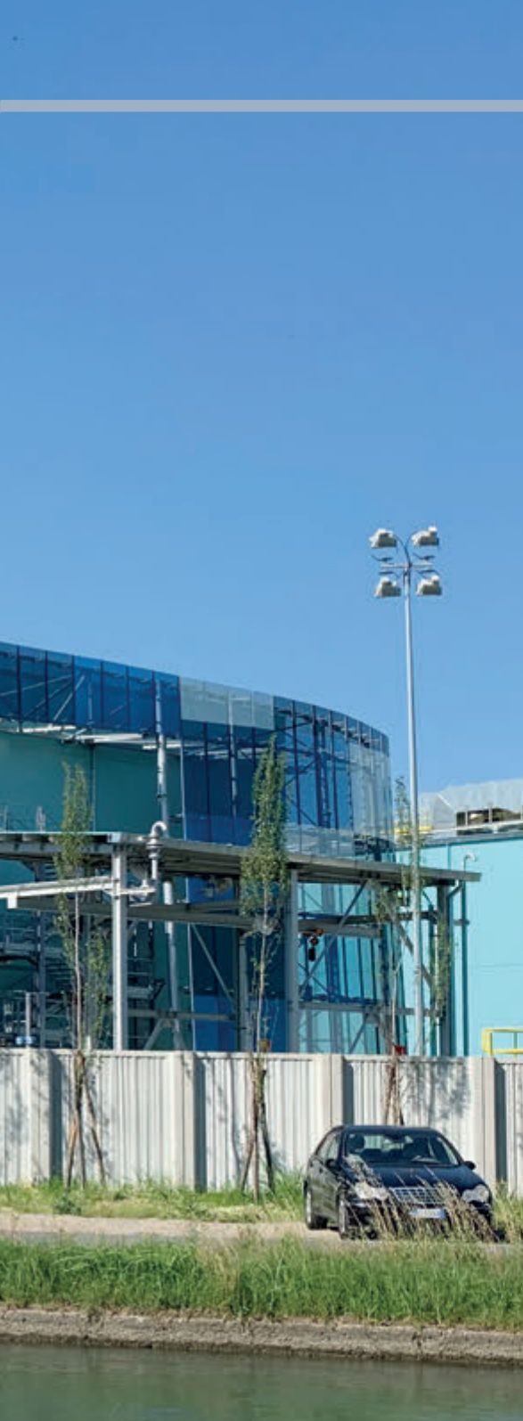
La struttura è formata da tubolari di acciaio D.N. 150 per i pilastri e i traversi.
