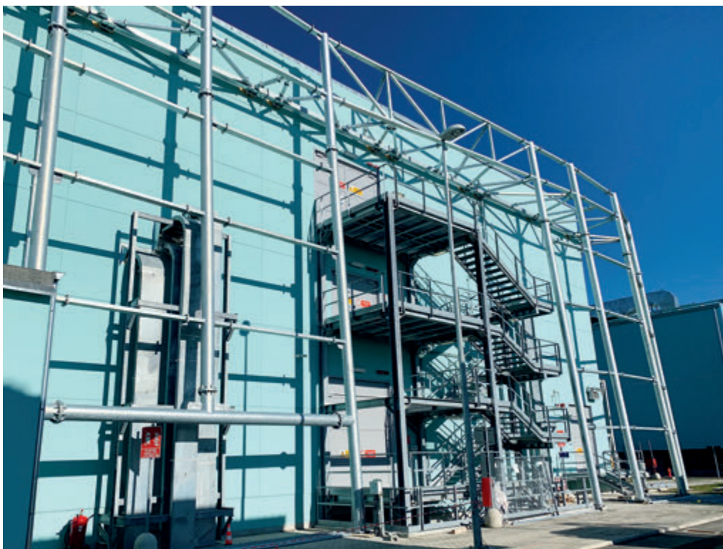
Sono incluse le reticolari orizzontali poste in sommità per collegare la quinta esterna ai corpi di fabbrica e le piastre per le unioni bullonate M16.
