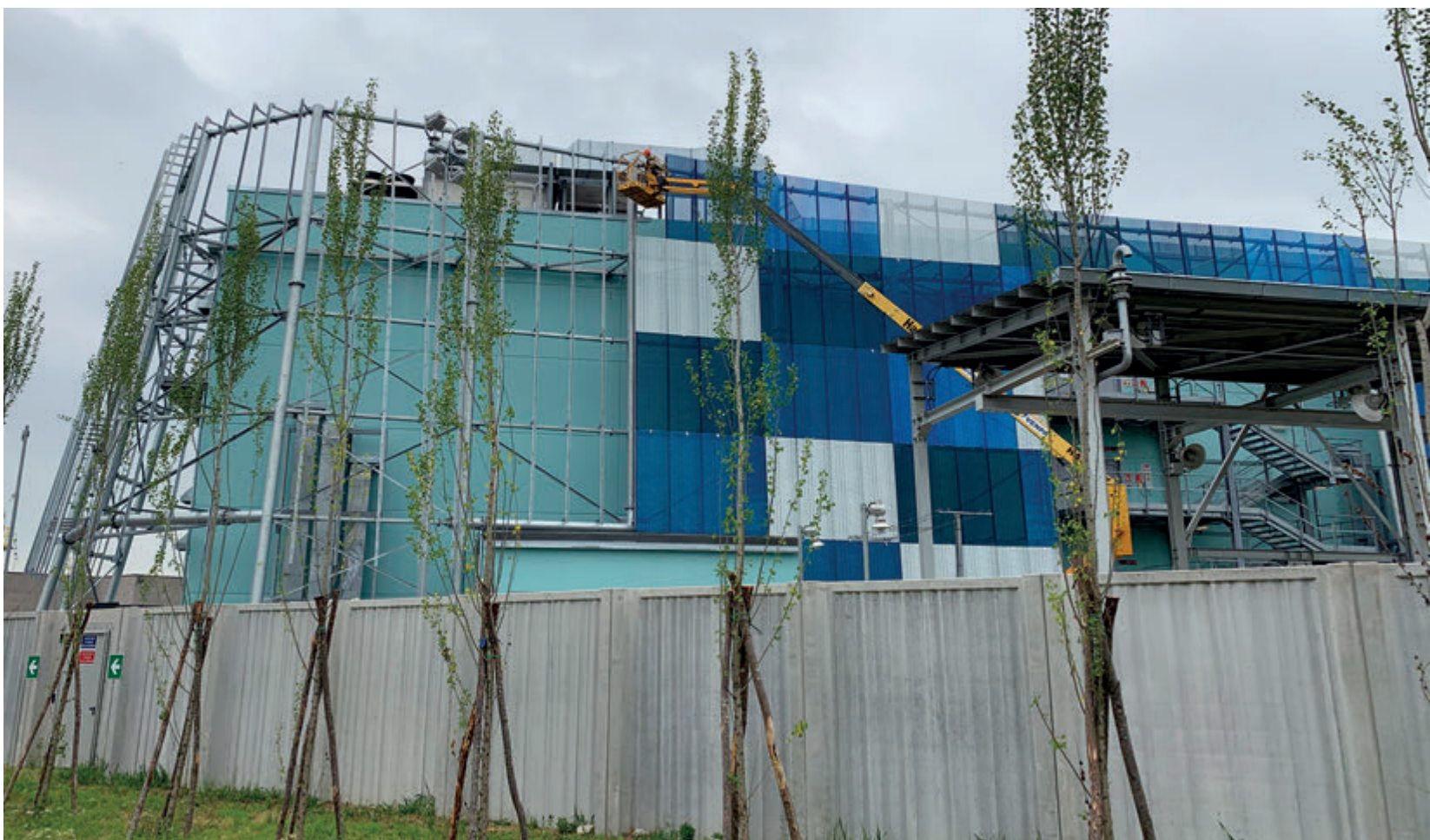
I tamponamenti verde acqua in calcestruzzo prefabbricato con doppia finitura vengono attenuati nella loro rudezza dall'onda esterna.
