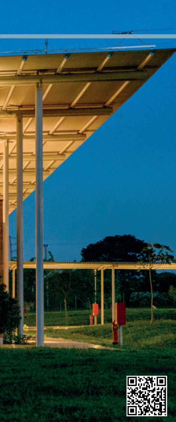
La struttura che sostiene i solai è costituita da una serie di telai centrali a doppia altezza, coppie di colonne ancorate alla platea di fondazione, da una trave inferiore e da una trave superiore.
