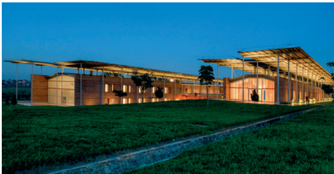
Il nuovo Ospedale di chirurgia pediatrica di Entebbe, in Uganda progettato, per Emergency da Renzo Piano Building Workshop insieme a Tamassociati.
