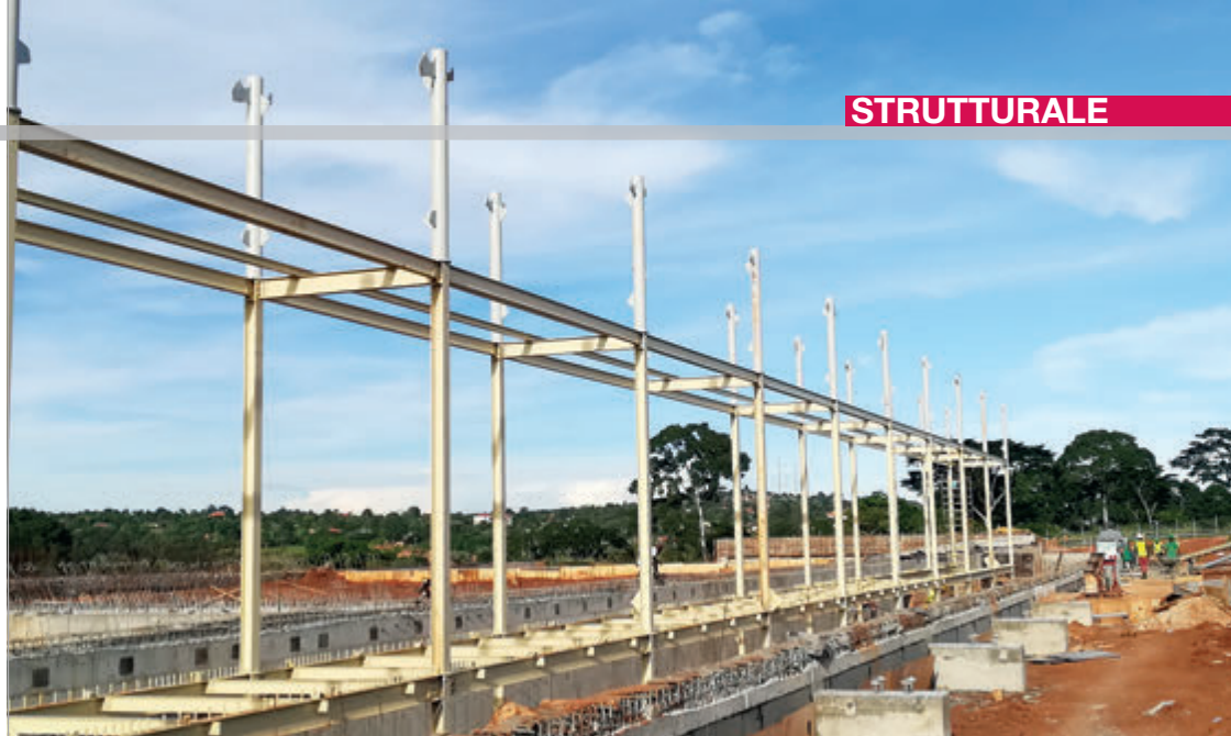
La struttura che sostiene i solai è costituita da una serie di telai centrali a doppia altezza, coppie di colonne ancorate alla platea di fondazione, da una trave inferiore e da una trave superiore.
