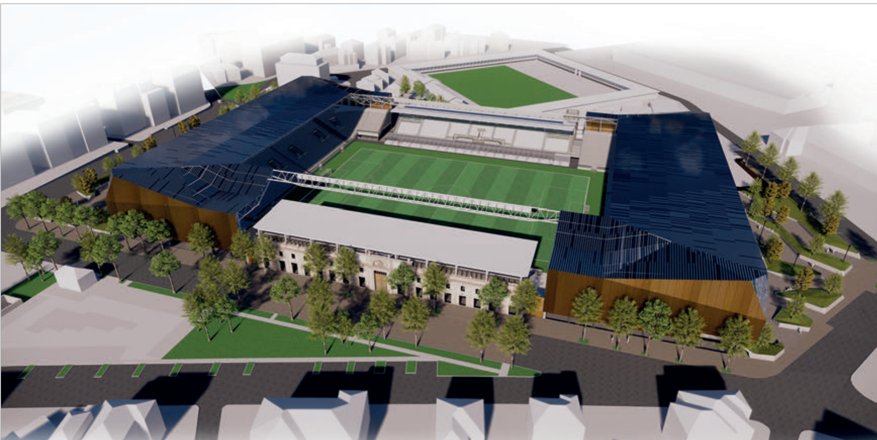
Le curve nord e sud esistenti sono state completamente sostituite da nuove tribune a ridosso del campo di gioco.
