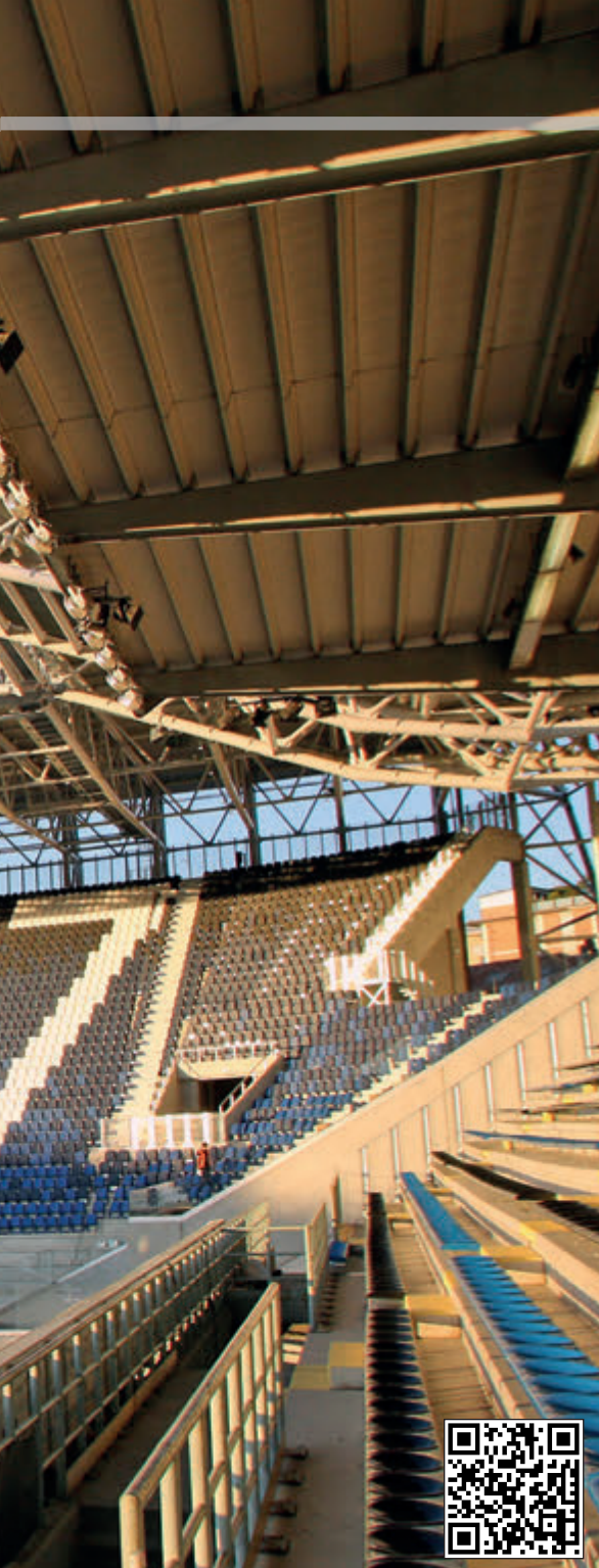
In facciata le curve sono avvolte da una pelle traslucida e da una grande copertura in acciaio progettata interamente con l'ausilio di programmi di modellazione BIM.
