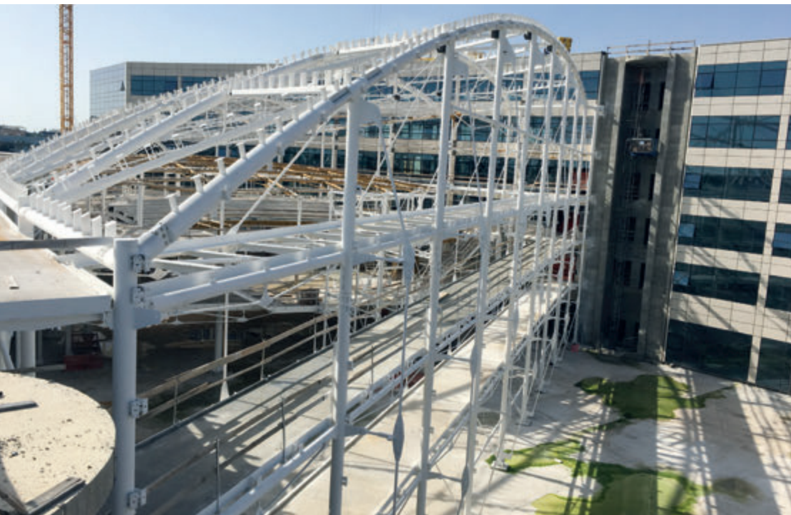
Strutturalmente la corte è realizzata in carpenteria metallica con profili tubolari circolari a sezione e spessori variabile da 48,3 x 5 mm a 323,9 x 20 mm.
