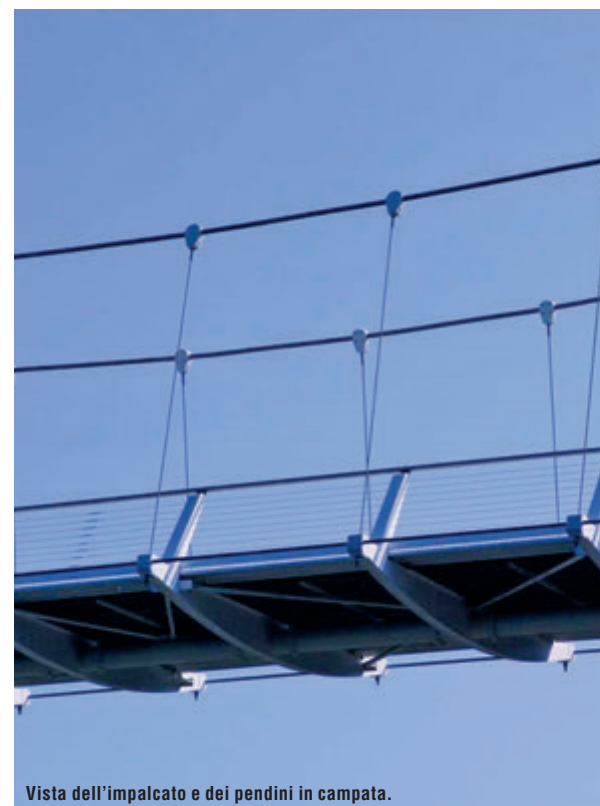
Vista dell'impalcato e dei pendini in campata.
