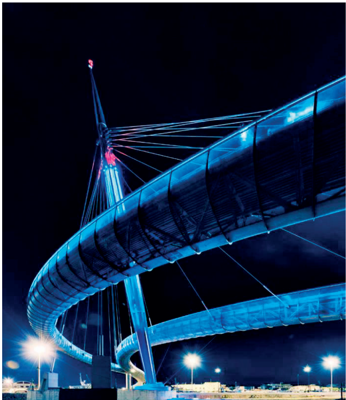
Il Ponte del Mare ha un impalcato con sistema di smorzamento per stabilità sotto l'azione del vento e dei pedoni.
