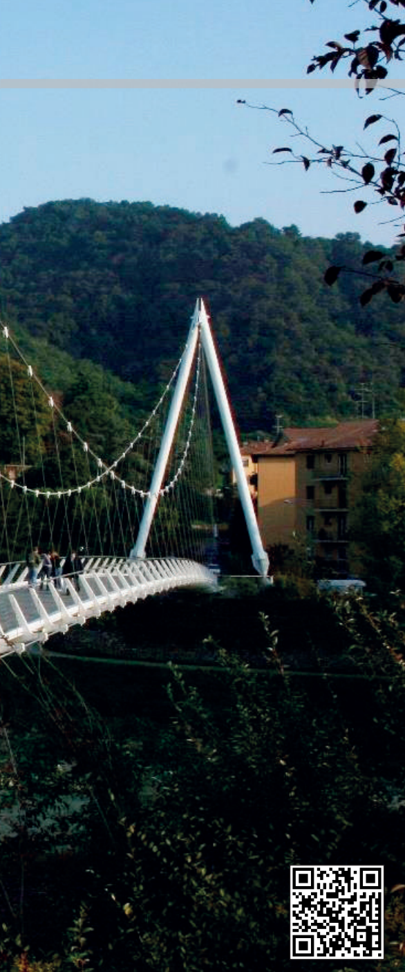
Particolare attenzione progettuale è stata dedicata alla massima riduzione delle vibrazioni indotte dalle azioni di moto pedonale sincronizzato.
