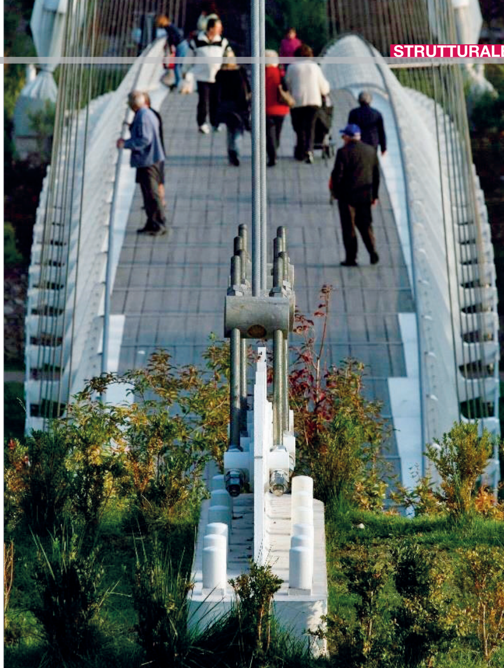
Particolare attenzione progettuale è stata dedicata alla massima riduzione delle vibrazioni indotte dalle azioni di moto pedonale sincronizzato.
