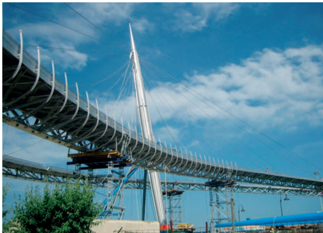
Vista durante una fase di cantiere.
