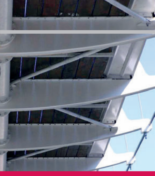
Vista delle gondole e del sistema di ancoraggio ai pendini.
