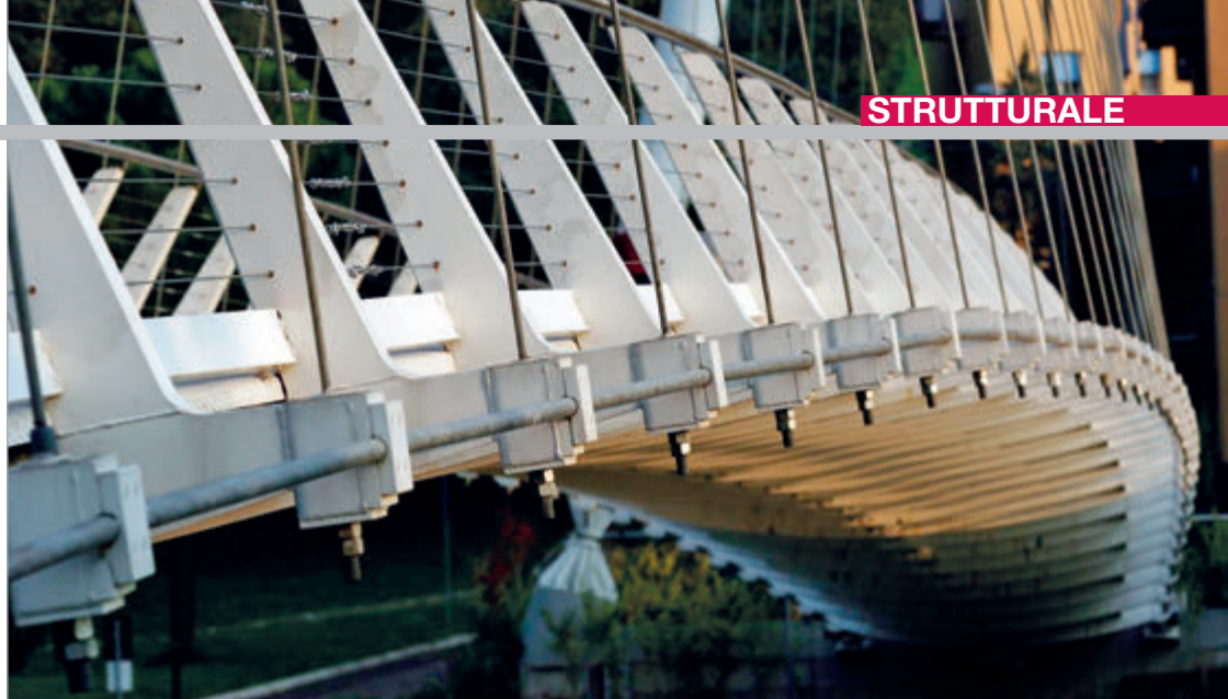
Vista delle gondole e del sistema di ancoraggio ai pendini.
