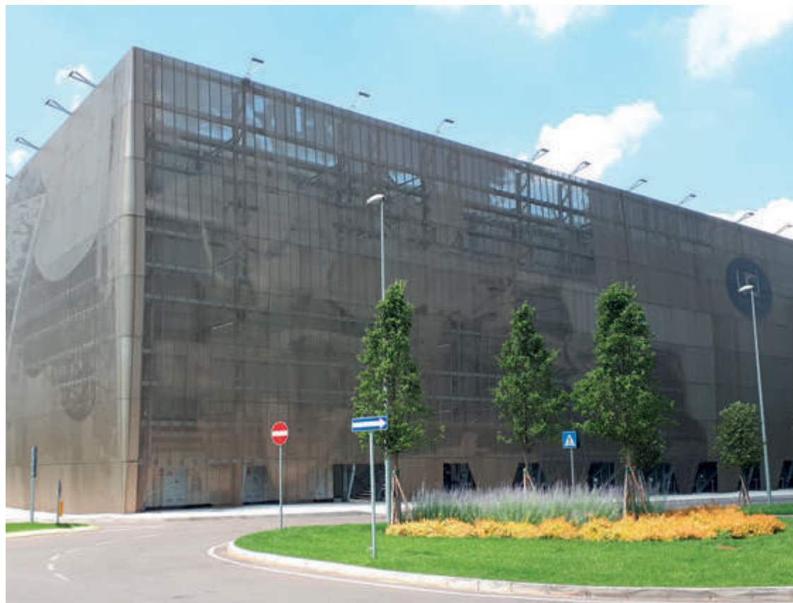
La pelle esterna, oltre a schermare visivamente le scale, modula l'aspetto esteriore del cinema, che non appare come un mero parallelepipedo ma come una struttura dai colori cangianti e vivaci.
