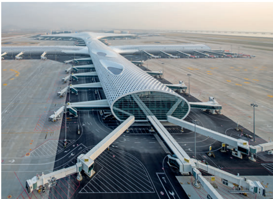
L'involucro del Terminal 3 è formato verso l'esterno da pannelli sandwich, dall'isolamento acustico posto sulla pelle interna e da forature alveolari passanti, le cui vetrate illuminano naturalmente lo spazio sottostante.
