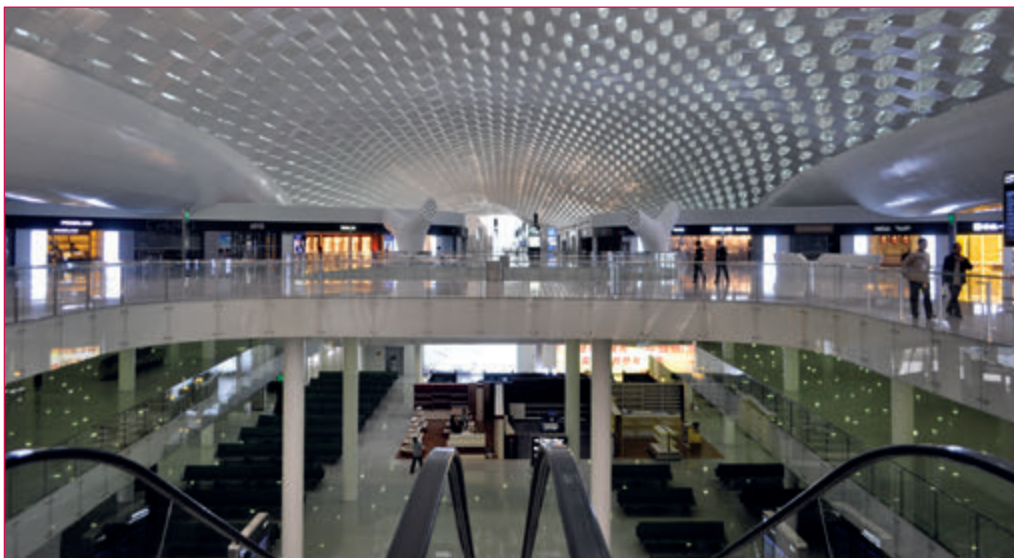
L'incrocio del concourse con il corpo trasversale origina una piazza, costituita da un vuoto a tutt'altezza e caratterizzato da una luce libera di 80 m.
