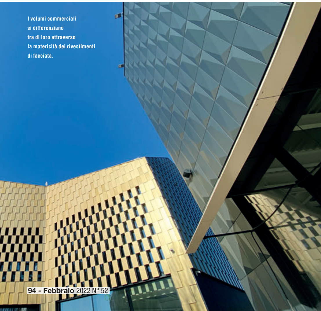
La struttura principale è in carpenteria metallica ed è stata realizzata con 2.600.000 kg di profilati laminati a caldo.
