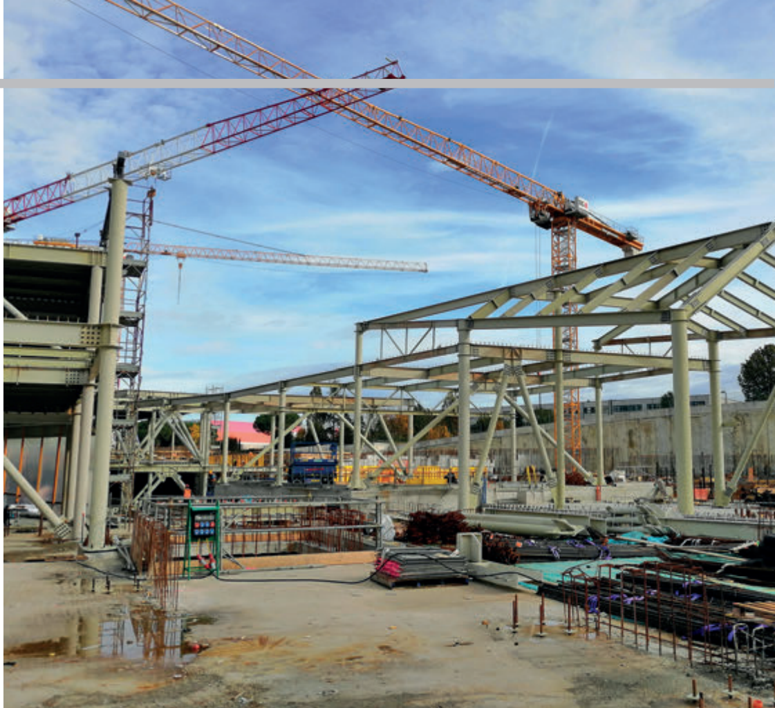
La struttura principale è in carpenteria metallica ed è stata realizzata con 2.600.000 kg di profilati laminati a caldo.
