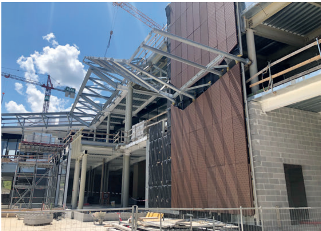
Nel progetto è stata adottata una maglia di pilastri tubolari a sezione circolare \varnothing 610 mm e sp. 30 mm in acciaio in qualità S355.
