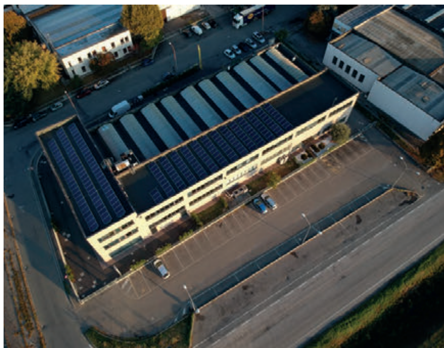
LA SEDE DI ENERGY GROUP È A BENTIVOGLIO, IN PROVINCIA DI BOLOGNA.
