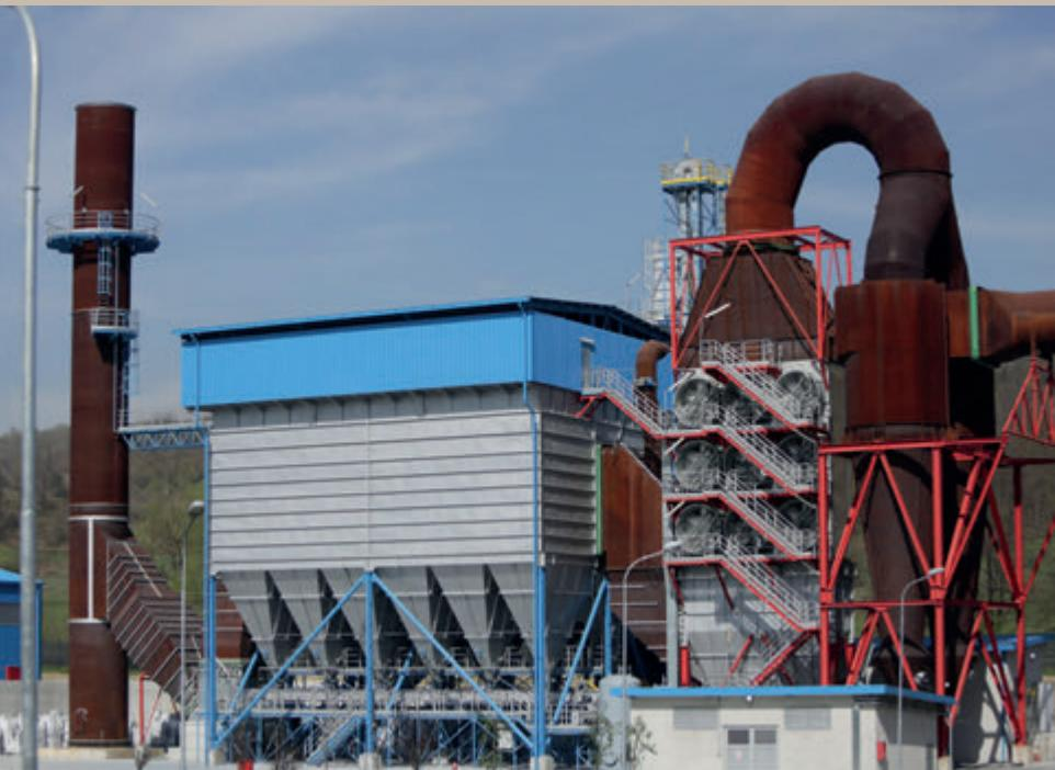
Lo stabilimento di Mrkonjić Grad (ex R-S Silicon) è un impianto greenfield fondato dal Gruppo Metalleghe nel 2012. È stato costruito nel 2016, quando è stata avviata la produzione. Il cuore dell'impianto è un forno ad arco sommerso da 22 MW di potenza installata totale, con una
